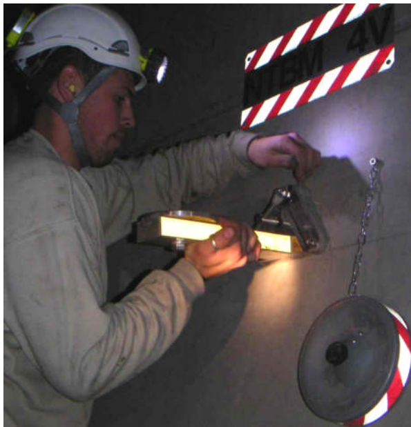
Unikonsol demonteras.
