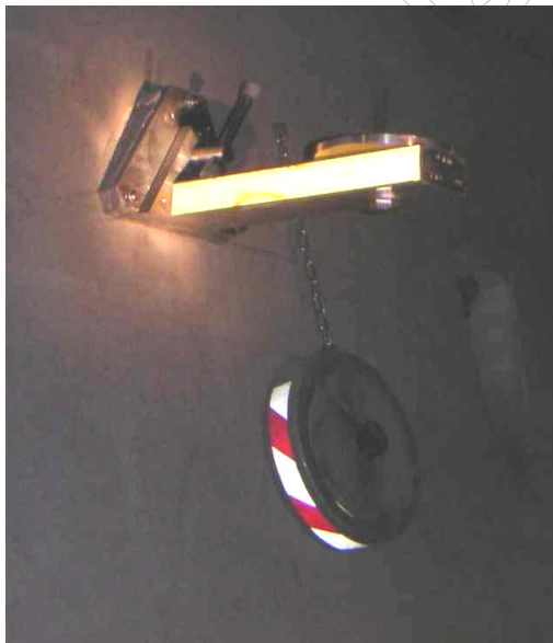
UNIKONSOL monteras. Monteringsplattan på bilden är undergjutet.
