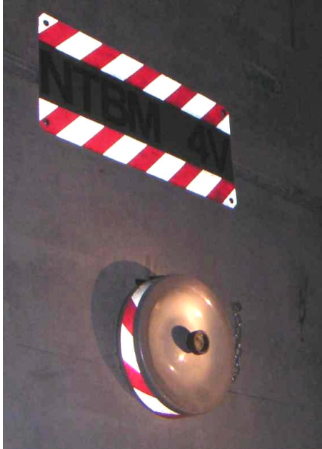
Montageplatta med skyddskåpa och ID-bricka Kåpan är centriskt fäst i mätarens M10-gänga (svart knapp i bilden)
